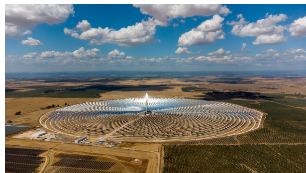
La energía termosolar: es aquella que recolecta el calor del sol para concentrarlo sobre un fluido y lo evapora para producir la energía necesaria
